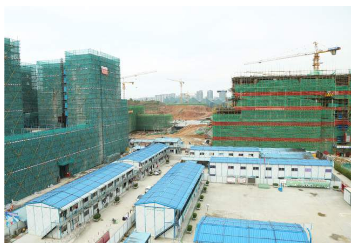
教学楼 Teaching Building (2016 年 1 月 January, 2016)
