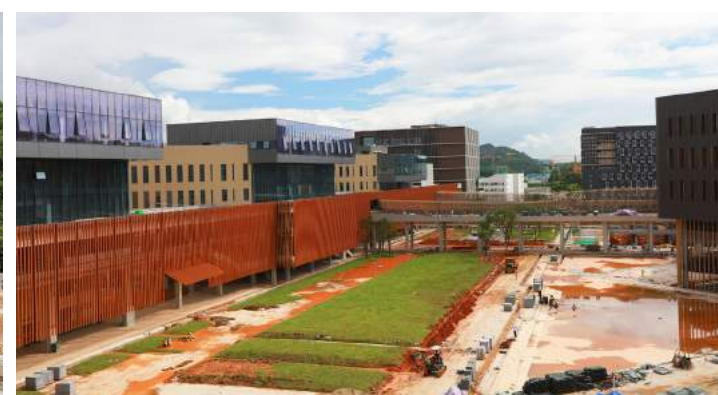
实验楼 Research Building (2017 年 4 月 April, 2017)
