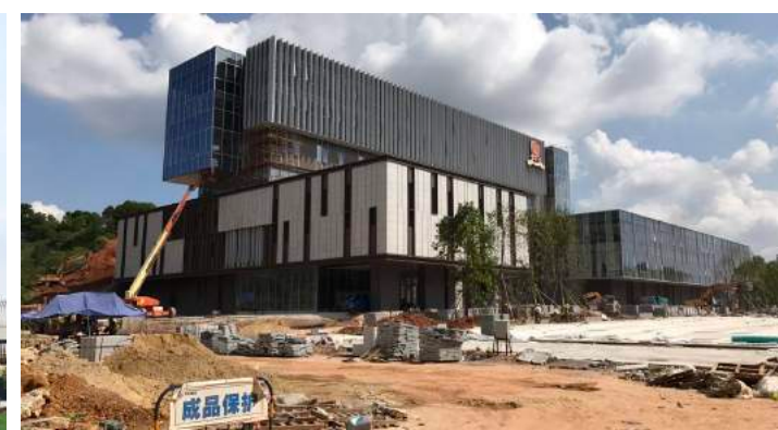
行政楼 Administration Building (2017 年 4 月 April, 2017)
